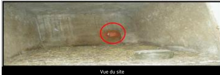
Vue du site
