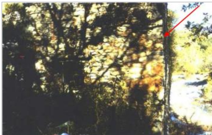
Vue du site
