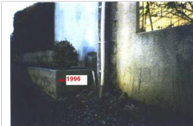
mur d'enceinte - rive gauche
