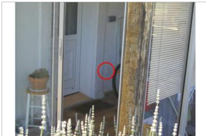
Entrée en façade de l'ancienne maison S.N.C.F, sous la verrière
