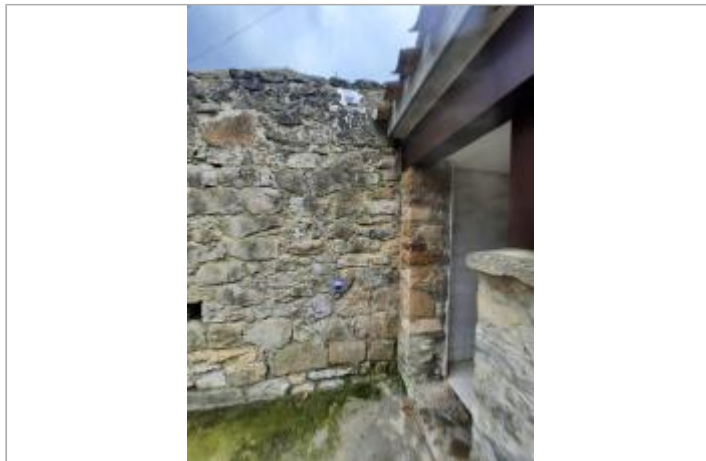
site au niveau du pont Vieux
