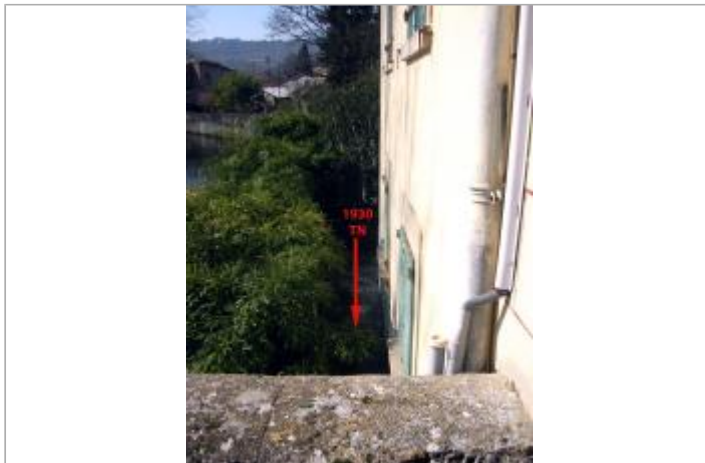
Vue du site
