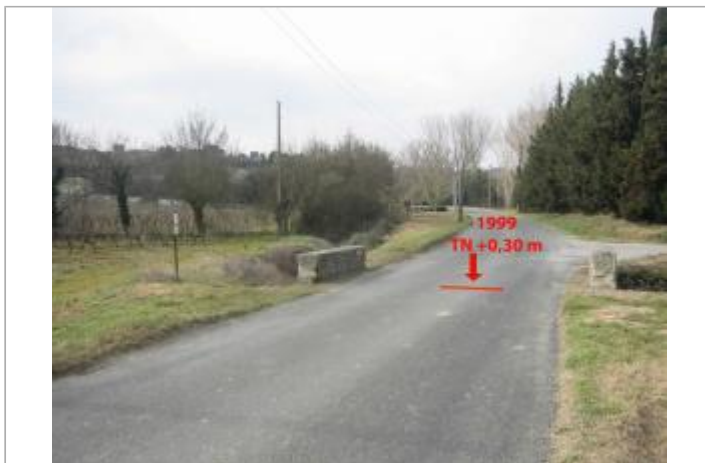
Vue du site
