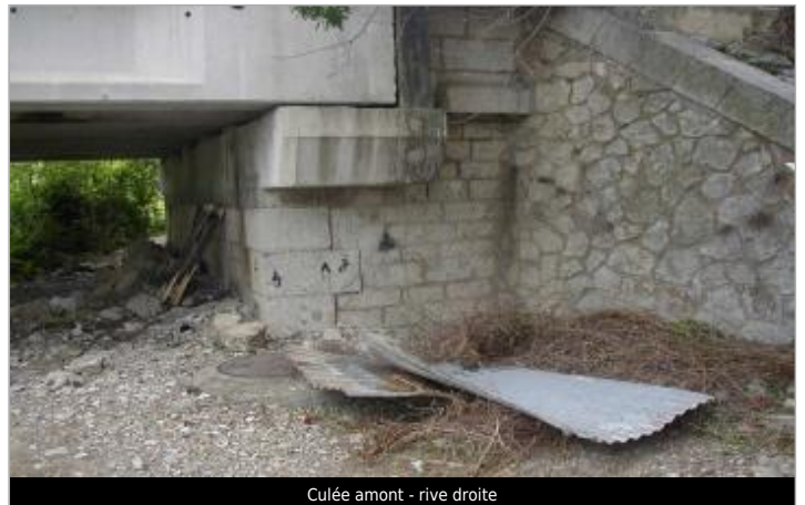
Culée amont - rive droite
