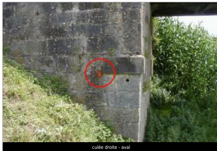
culée droite - aval
