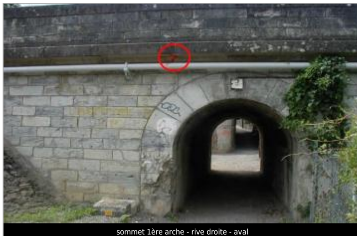
sommets 1ère arche - rive droite - aval
