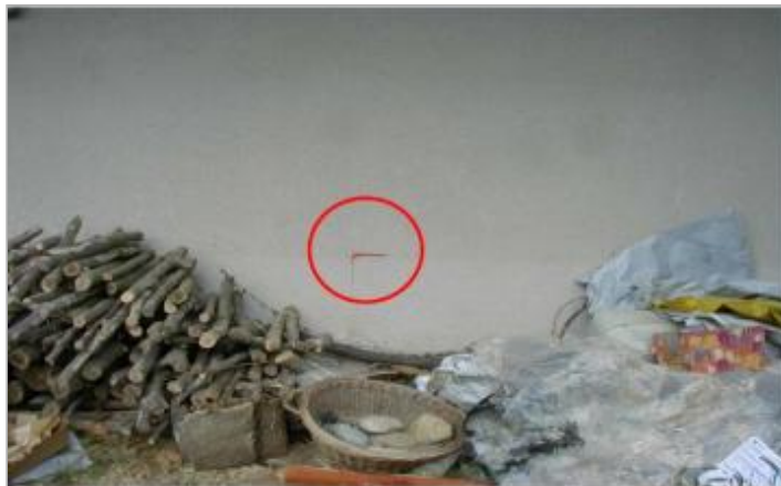
mur garage - rive droite
