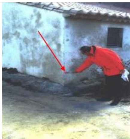
Angle des murs extérieur de la maison rive gauche.
