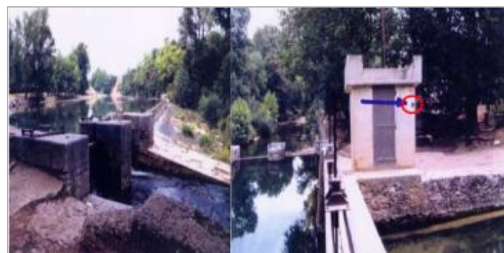
façade de l'abri de rangement - rive droite
