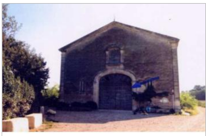
piédroit du portail - rive gauche
