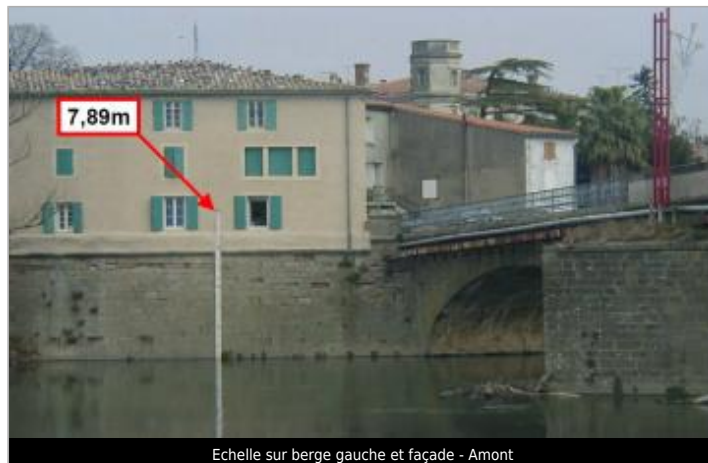
Echelle sur berge gauche et façade - Amont
