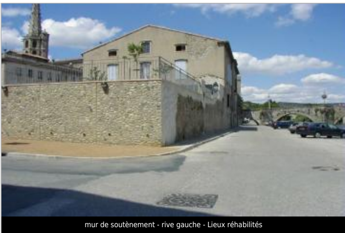
mur de soutènement - rive gauche - Lieux réhabilités
