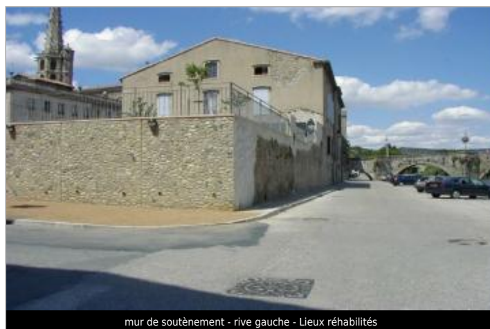
mur de soutènement - rive gauche - Lieux réhabilités
