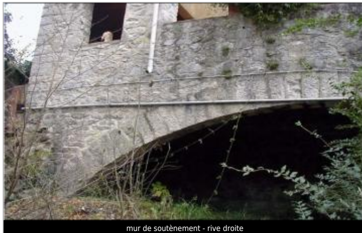
mur de soutènement - rive droite
