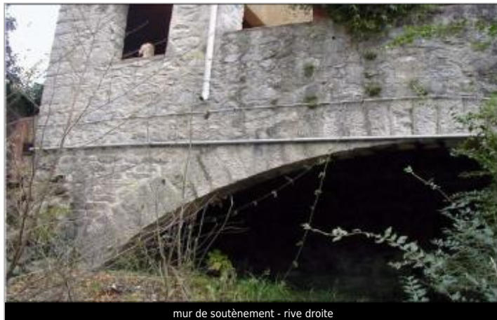
mur de soutènement - rive droite
