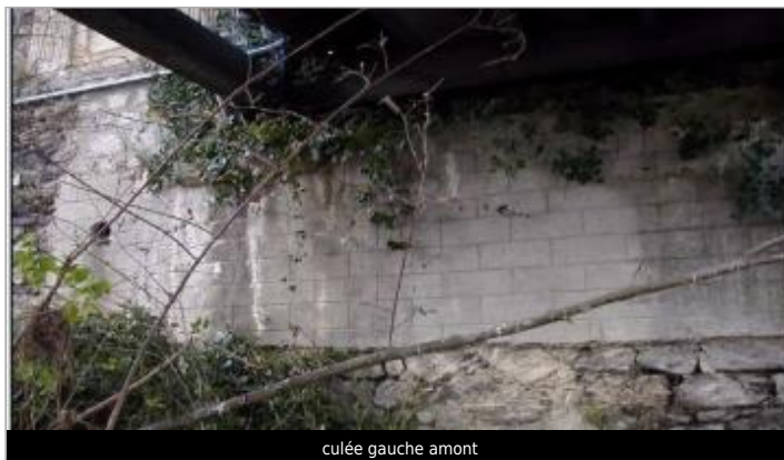
culée gauche amont
