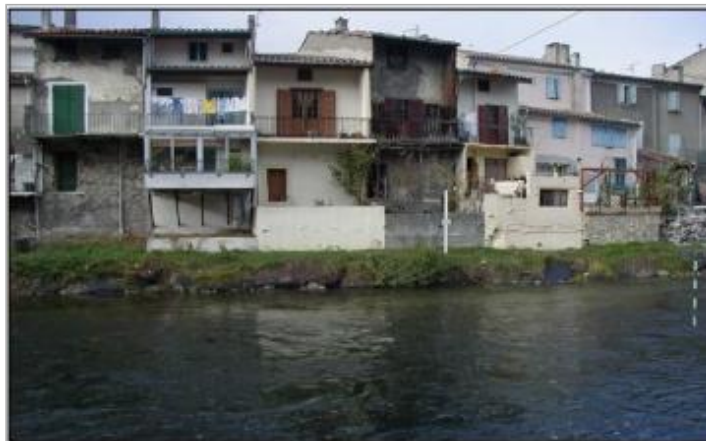
mur de soutènement - rive gauche
