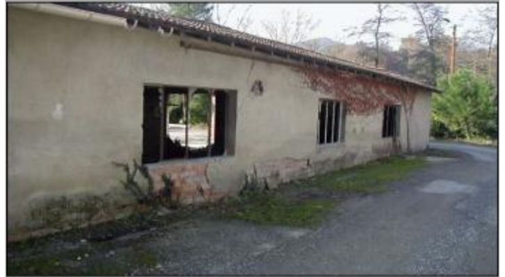
mur bâtiment désaffecté - rive droite
