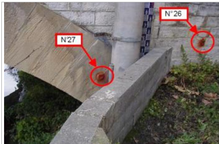
culée gauche aval
