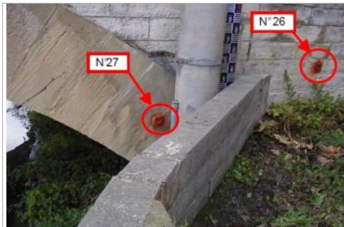
culée gauche aval
