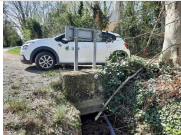
sous le panneau de direction - rive droite
