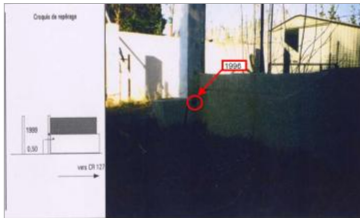
mur d'int. de la bâtisse - rive gauche canal
