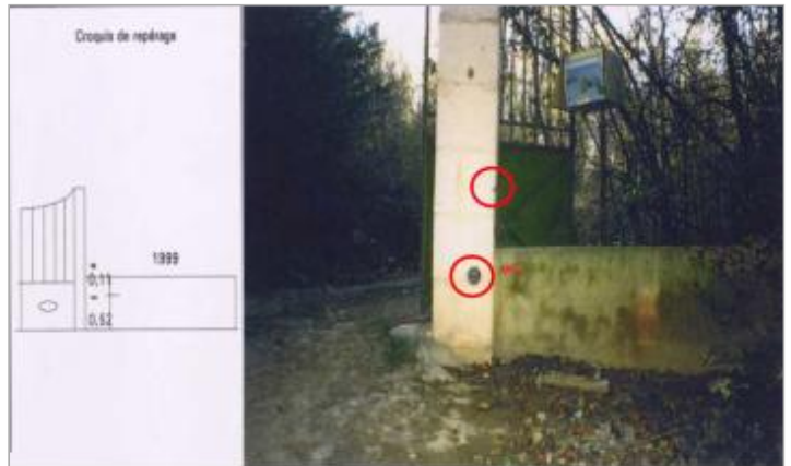
pilier droit de portail - rive droite
