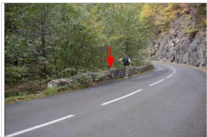
mur de soutènement - rive gauche
