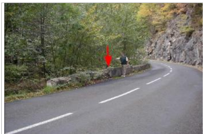
mur de soutènement - rive gauche
