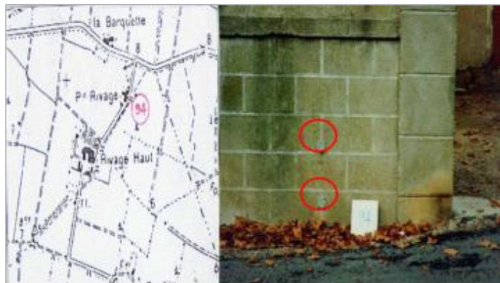
transformateur EDF - rive gauche
