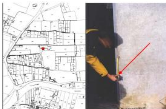
piédroit de portail de hangar - rive gauche
