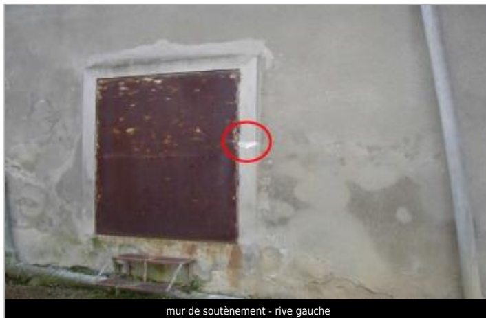
mur de soutènement - rive gauche
