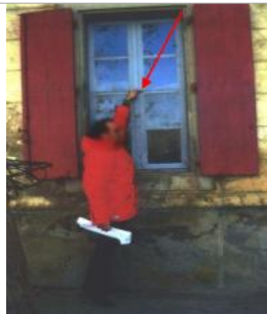
Vue du site
