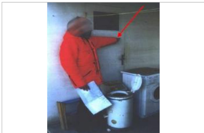
porte intérieure de la lingerie - rive droite
