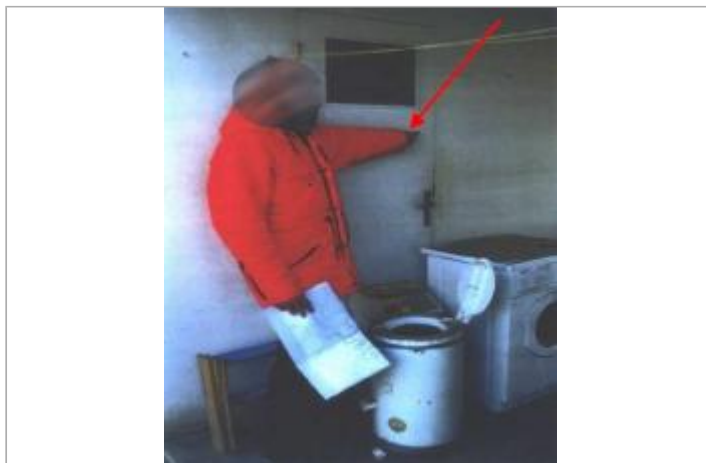
porte intérieure de la lingerie - rive droite
