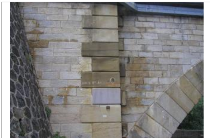
culée gauche amont
