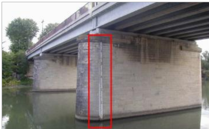
Echelle limnimètre accolée sur pile gauche aval
