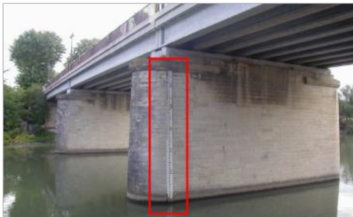
Echelle limnimètre accolée sur pile gauche aval
