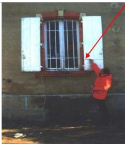
façade de la Poste-volets - rive droite
