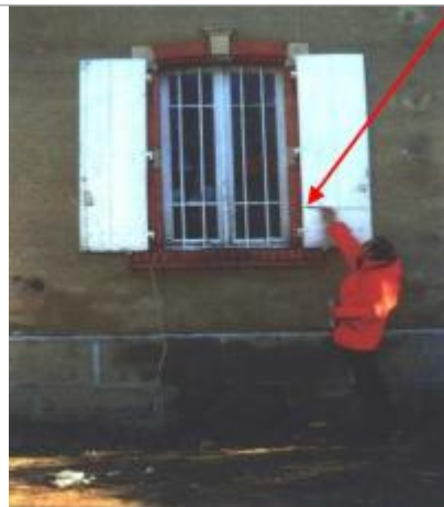
façade de la Poste-volets - rive droite
