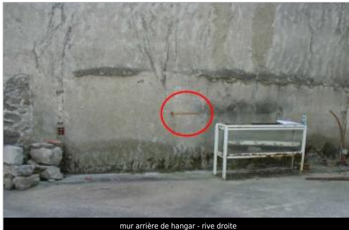
mur arrière de hangar - rive droite
