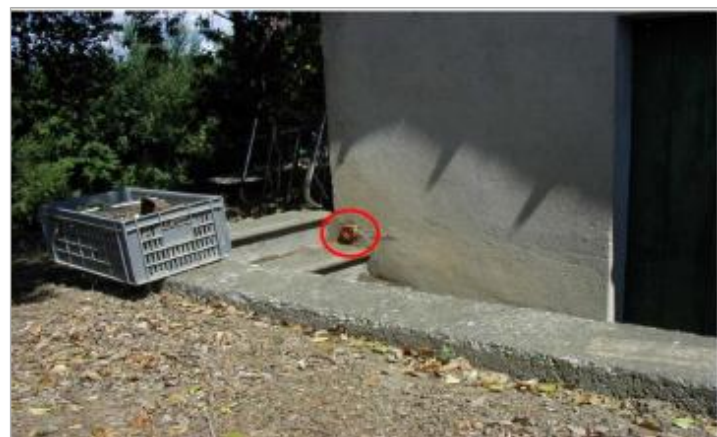
Façade rive droite - station de pompage
