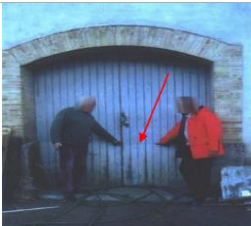
portail d'entrée de l'atelier de menuiserie - rive droite
