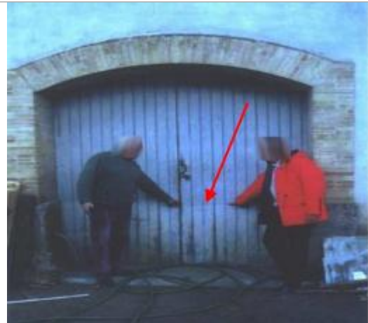
portail d'entrée de l'atelier de menuiserie - rive droite
