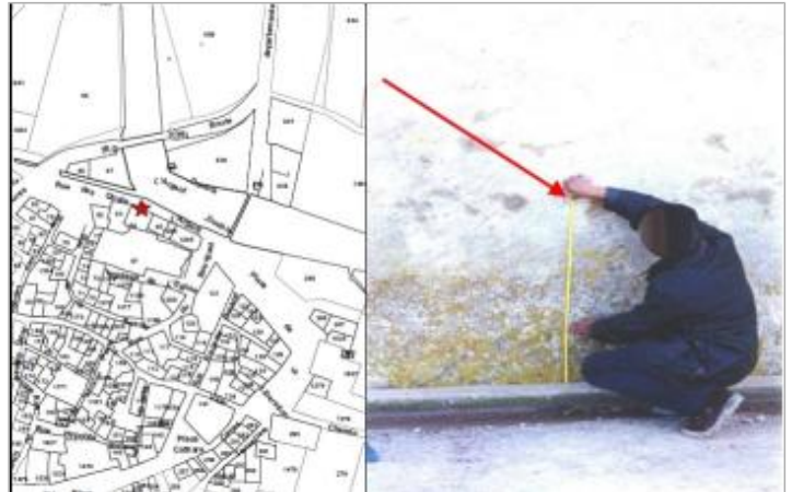
mur du bâtiment - rive droite
