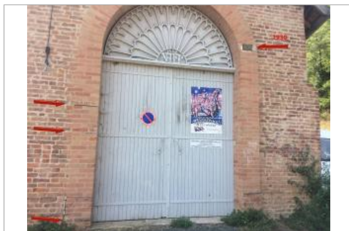
Vue des repères
