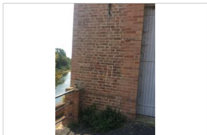
Vue des repères
