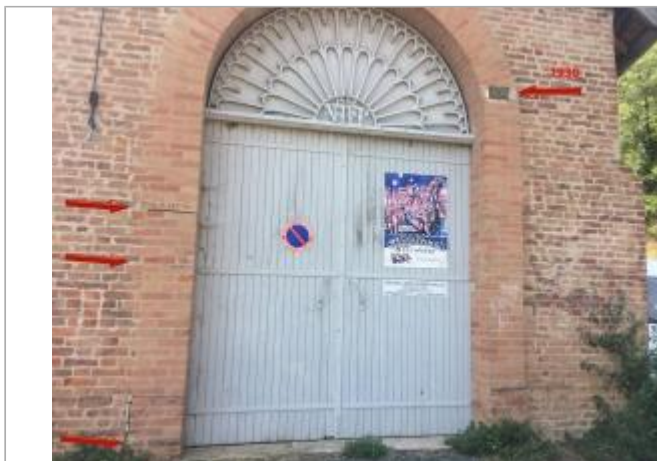
Vue des repères
