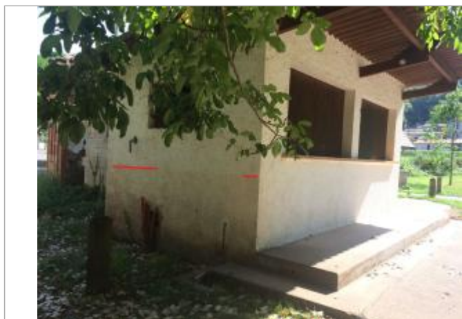
Le trait rouge marque le niveau atteint par la crue du 28/11/2014
