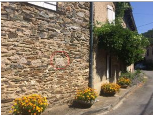
Le repère, aujourd'hui disparu, était fixé au centre du cercle rouge. Le béton de scellement est toujours présent.
