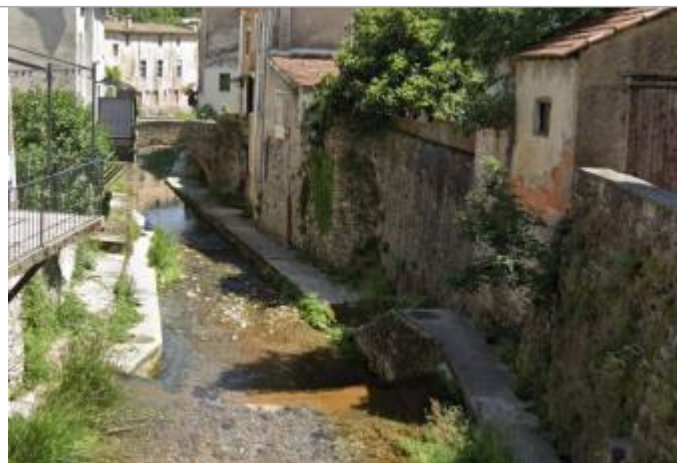
Vue du site ( Pont de Chazal)
