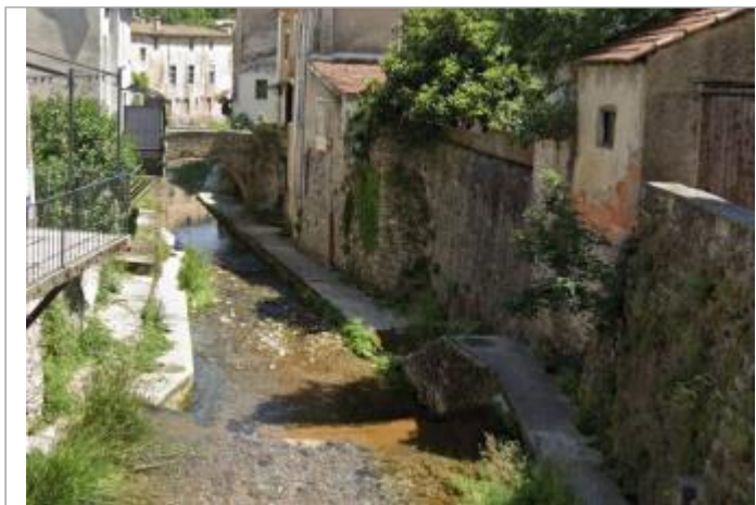
Vue du site ( Pont de Chazal)
