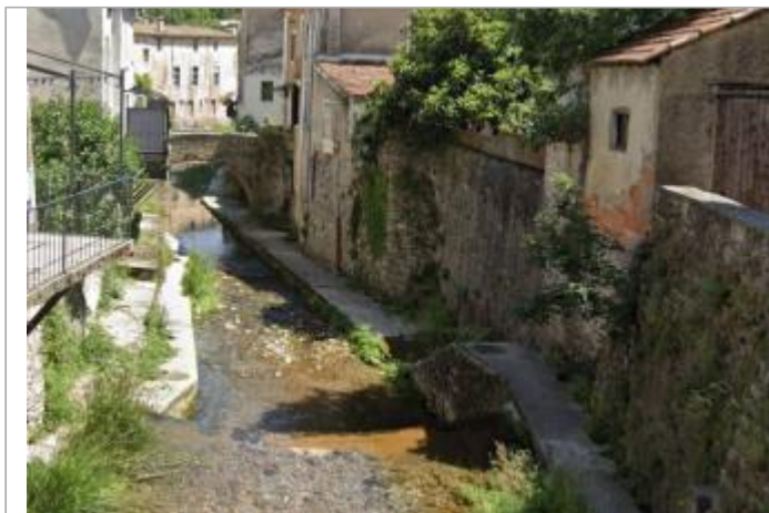
Vue du site ( Pont de Chazal)
