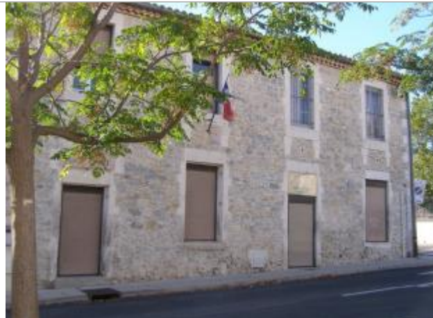
Vue du site
