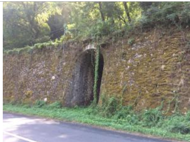
Vue de l'arche depuis la route
