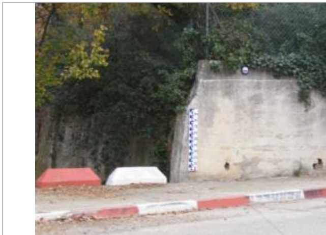
Vue du site
