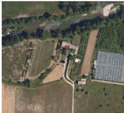
Vue du site
