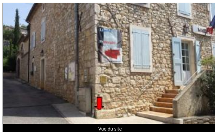
Vue du site
