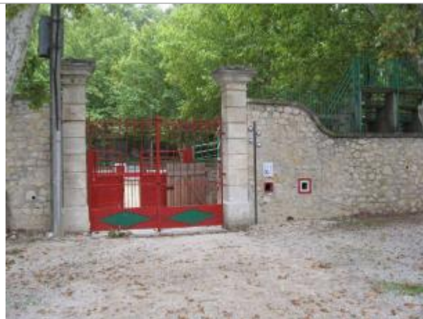
Vue du site
