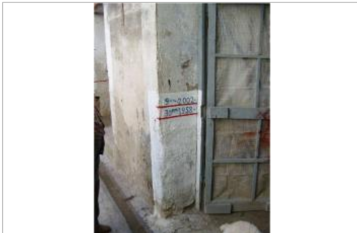
Vue du site
